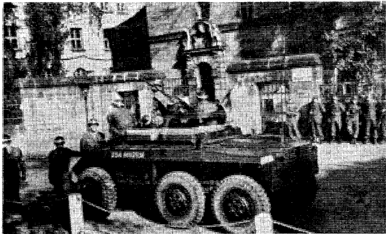
Justisbygningen i Nürnberg var under hele den såkalte prosess sikret dag og natt av tungtbevæpnede tropper og stridsvogner
