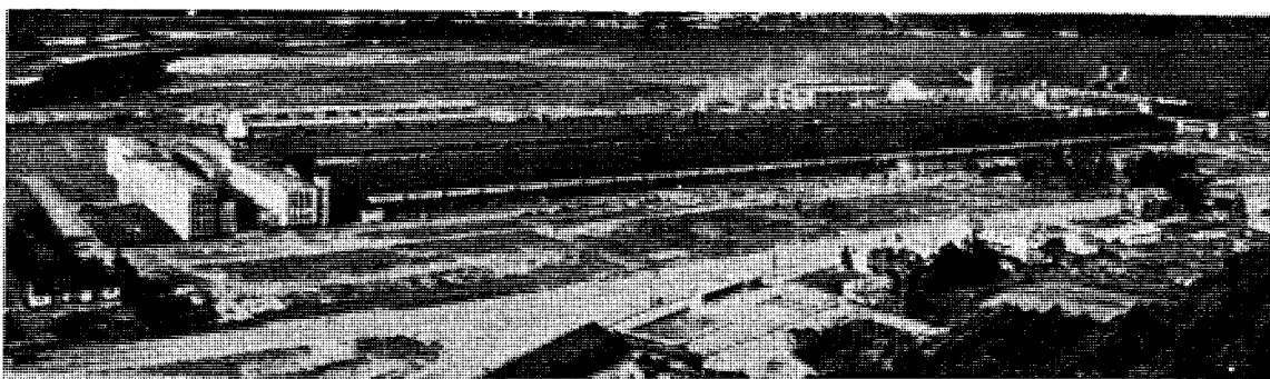
Aluminiumsverket på Sunndalsøra.
