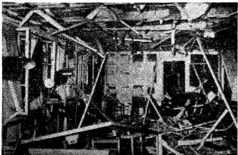
Det var nesten utrolig at noen kunne komme levende ut av dette rommet.
